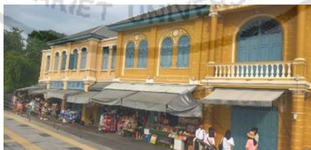
图3-22 塔昌码头店铺
