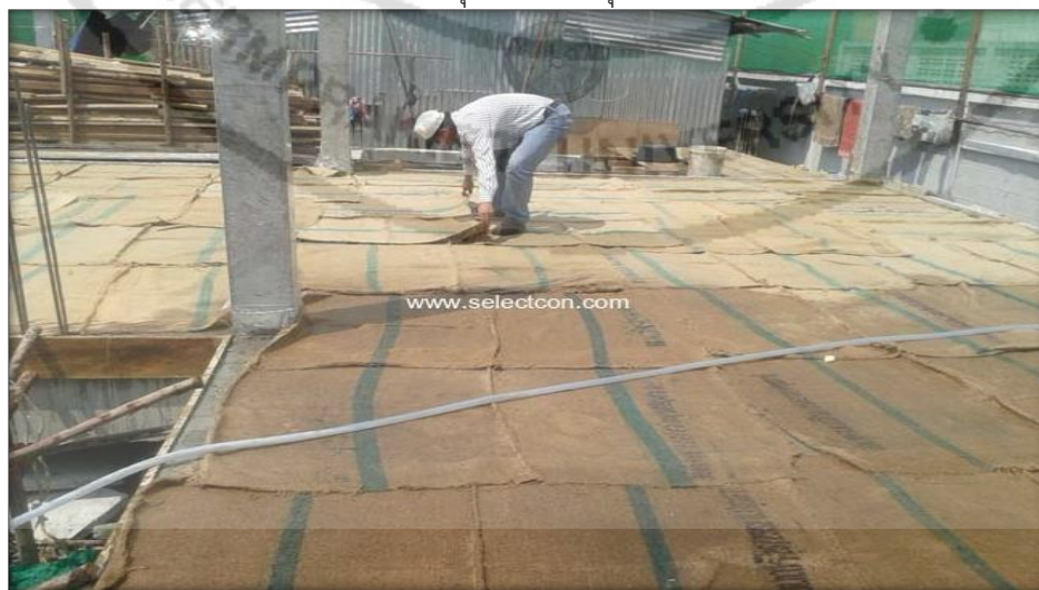
ภาพที่ 6 การบ่มคอนกรีตโดยใช้กระสอบคลุม รดน้ำให้ชุ่มตลอด 7 วัน
