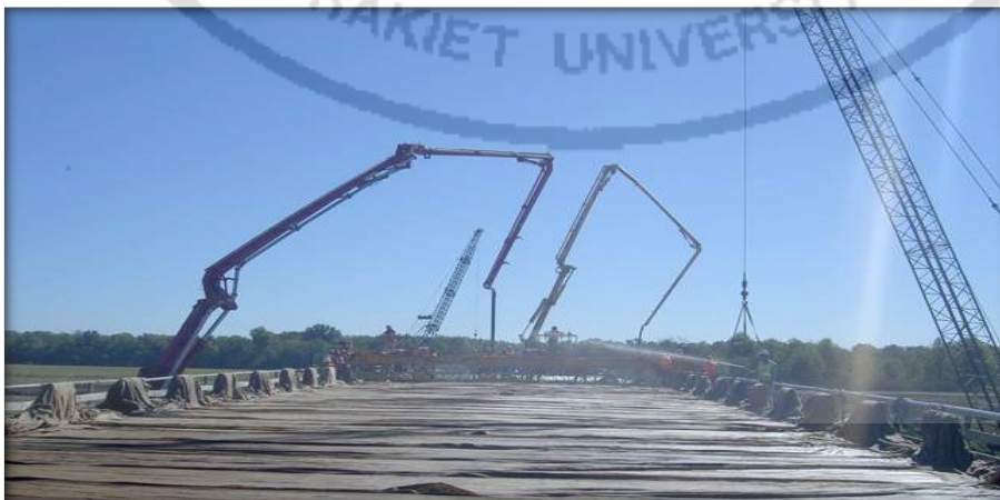
ภาพที่ 4 การบ่มคอนกรีตในงานสร้างสะพาน
