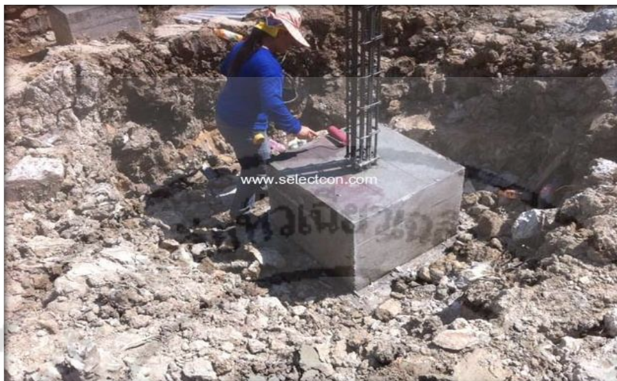
ภาพที่ 7 การบ่มคอนกรีตโดยการใช้น้ำยาบ่ม
