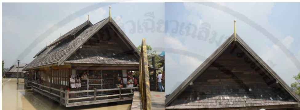
ภาพที่ 6 เรือนไทยภาคอีสานบนจั่วเรียกว่า ยอดตรง
