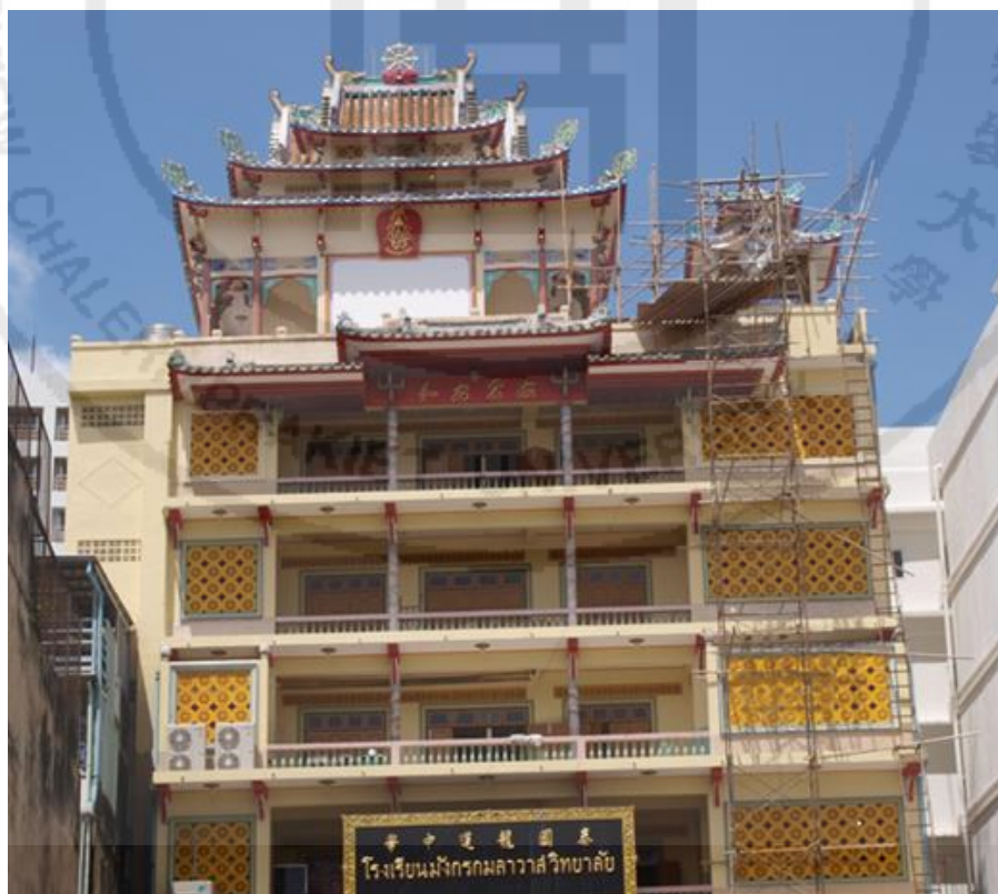
ภาพที่ 6 หลังคาโรงเรียนมังกรกมลาวาส
