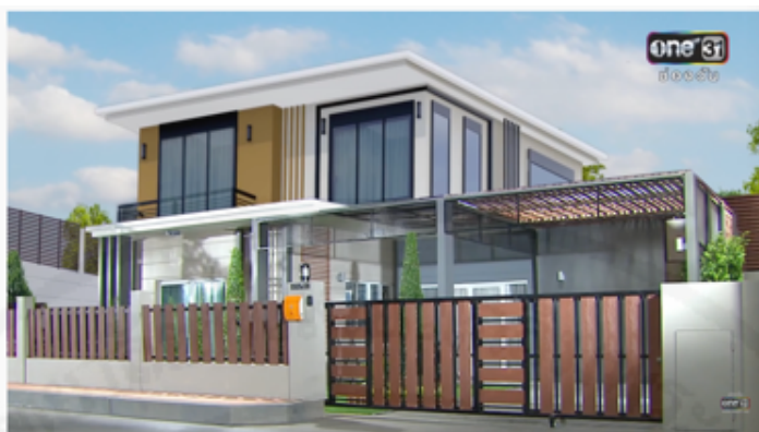
ภาพที่ 1 ลักษณะภายนอกของบ้านเดี่ยวในซีทคอม สุภาพบุรุษสุดซอย ตอน แค' ป.1 ก็อึ้งแหลัก
