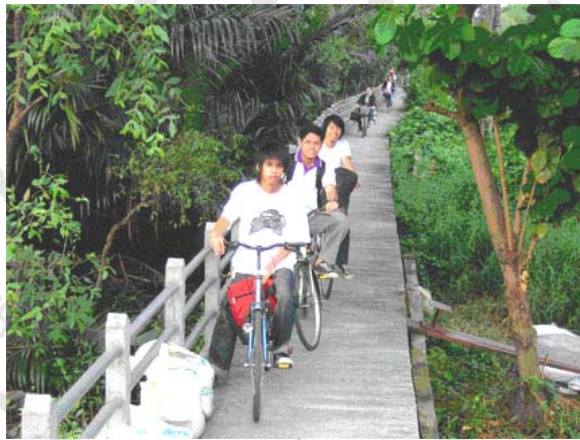
ภาพที่ 4-41 สะพานคอนกรีตที่มีด้านหนึ่งเป็นรั้วปูนซีเมนต์สูงประมาณ 60 เซนติเมตร
