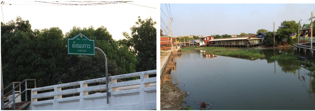
ภาพที่ 34 ภาพถ่าย สะพานคอนกรีตเชื่อมจากวัดบาง โลงในเข้าเกาะ ด้านขวาคือคลองอ้อมเกาะ เมื่อ พ.ศ. 2557
