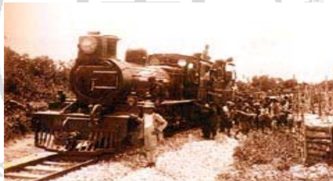
ภาพที่ 2-5 การสำรวจเส้นทางรถไฟสมัยก่อน
