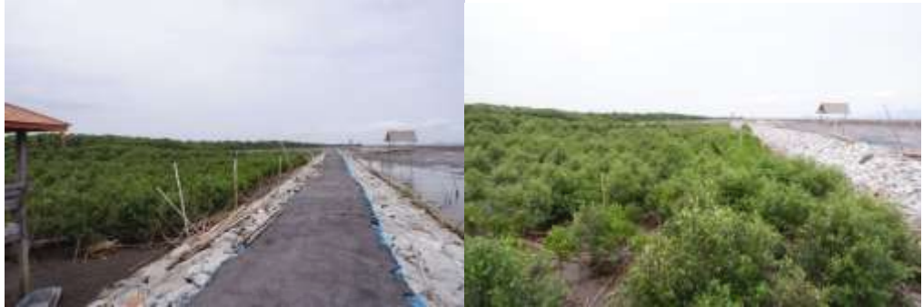
ภาพที่ 27. เขื่อนเรียงหินด้านนอกแนวป่าชายเลนที่บ้านสีลังตำบลคลองด่าน อำเภอบางบ่อ จังหวัดสมุทรปราการ พ.ศ. 2561.
